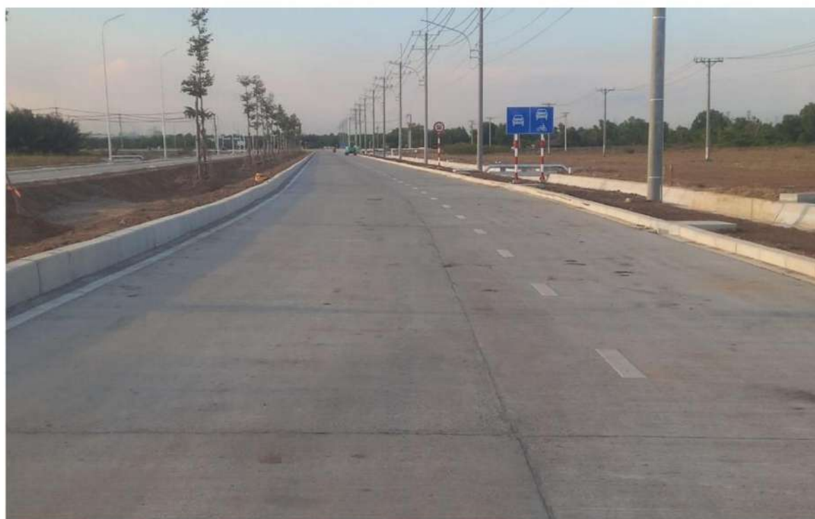
Dự án đầu tư xây dựng hạ tầng KCN công nghệ cao Long Thành
