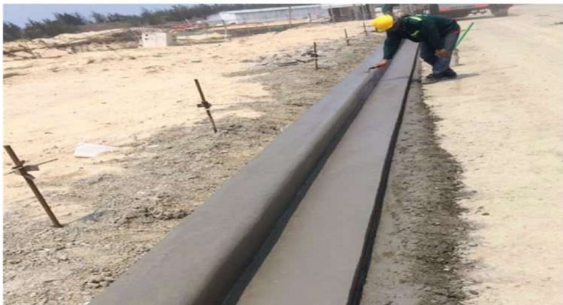
Công trình Hạ Tầng bó vỉa, Công ty Cao Su Đồng Nai , Địa điểm : Trảng Bom – Đồng Nai
