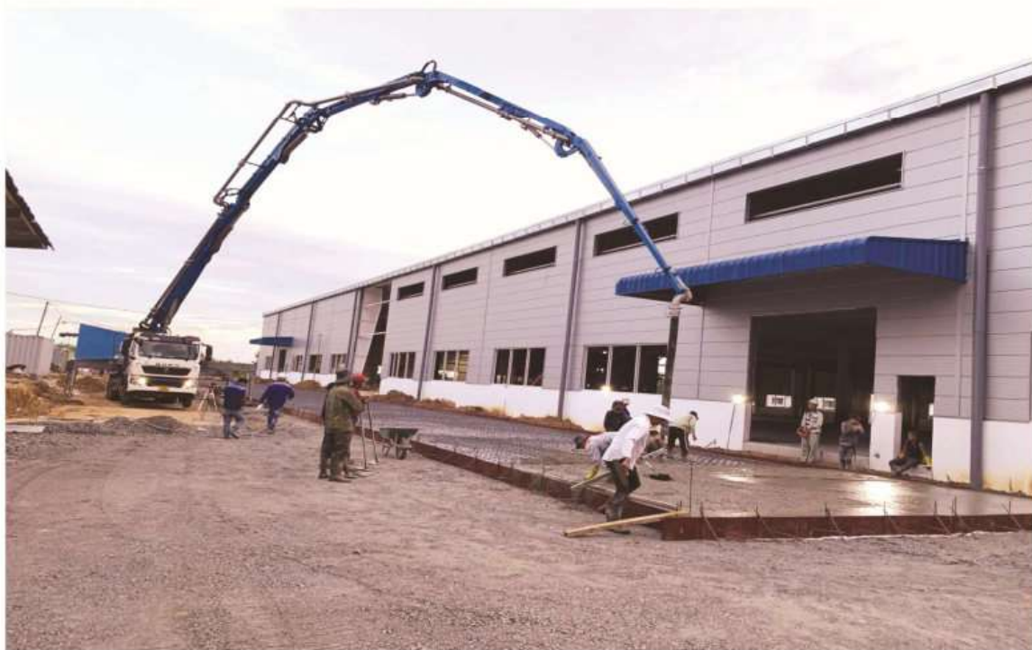
NHÀ XƯỞNG CTY ISUVINA KCN GIANG ĐIỀN
